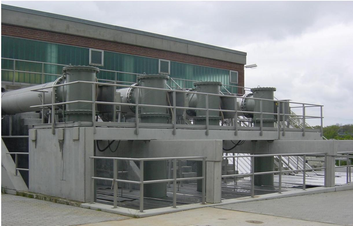
Das Pumpwerk ist seit 2002 in Betrieb. Nach 17 Jahren Betriebszeit sind die Rohrschächte in der Wasserwechselzone so stark Korrodiert, dass ein Austausch erforderlich wird. Die neuen Rohrschächte werden in Edelstahl ausgeführt um zukünftig Korrosionsprobleme zu vermeiden.
