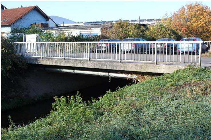
Abbildung 38: Brückenbauwerk über den Speyerbach und Gewerbebauten Adolf-Kolping- Straße, Blick Richtung Westen
