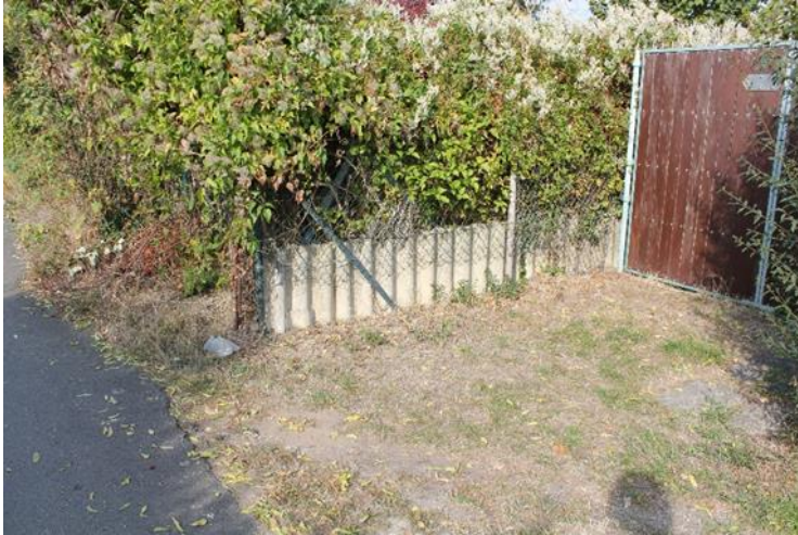
Abbildung 7: Faserzementplatten, Kleingärten am Harthäuser Weg/Rehbach
