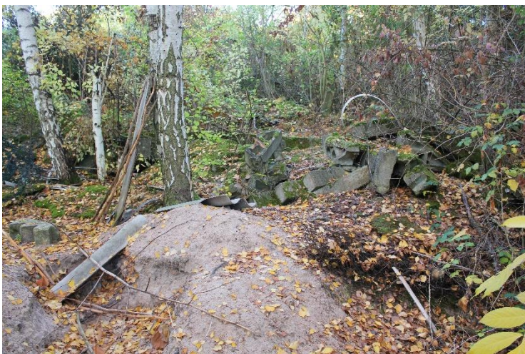
Abbildung 18: Betonprofile und Faserzementplatten auf tiefer liegendem Gelände
