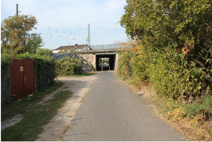
Abbildung 48: Eisenbahnüberführung in Verlängerung Harthäuser Weg, Blick Richtung Westen
