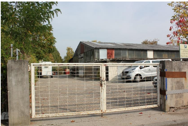
Abbildung 35: Gewerbegebiet Rosslauf, Blick Richtung Norden
