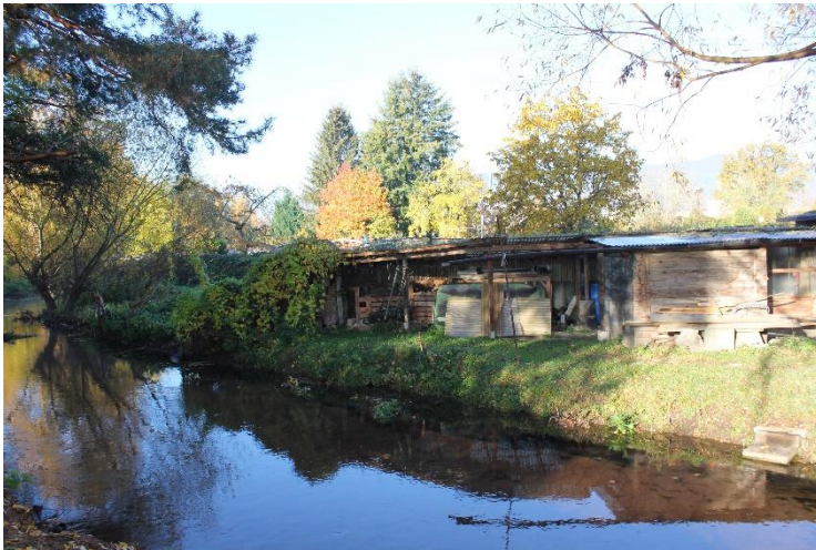
Abbildung 13: Bebauung mit Konstruktionshölzern im Bereich der Kleingartenanlagen am Harthäuser Weg/Rehbach
