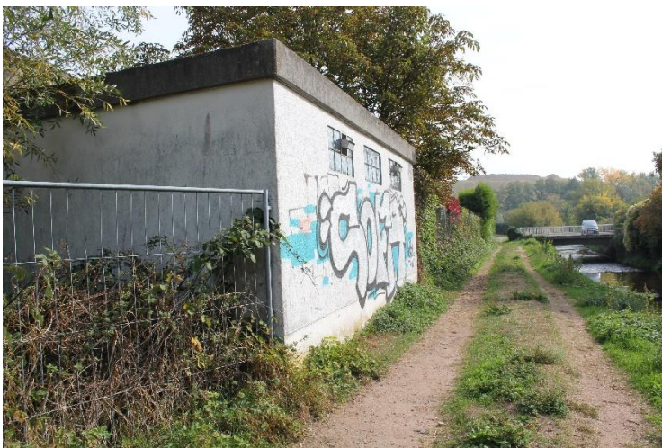
Abbildung 40: Ehemaliger Gewerbebau der Fa. Schüpferling, Adolf-Kolping-Straße angrenzend zu Teilfläche I c
