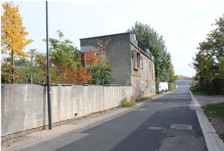
Abbildung 34: Gewerbegebiet Rosslauf, Blick Richtung Osten
