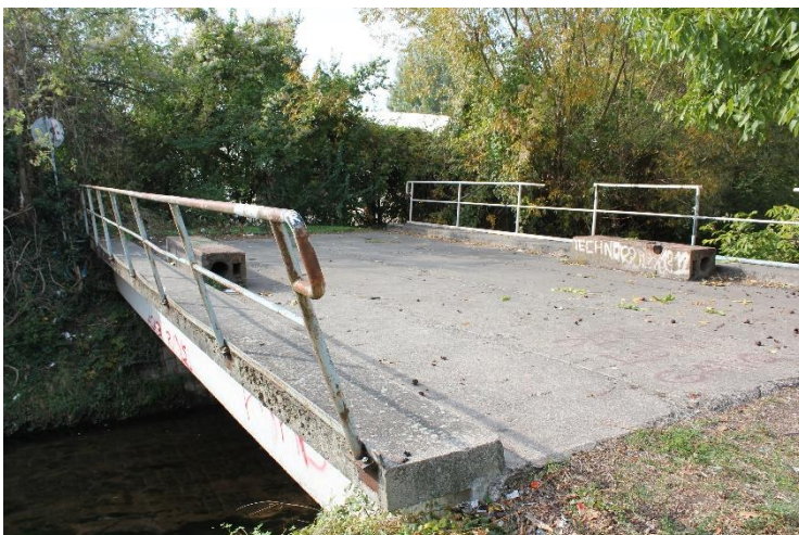
Abbildung 21: Betonbrücke über den Speyerbach auf das Rosslaufgelände
