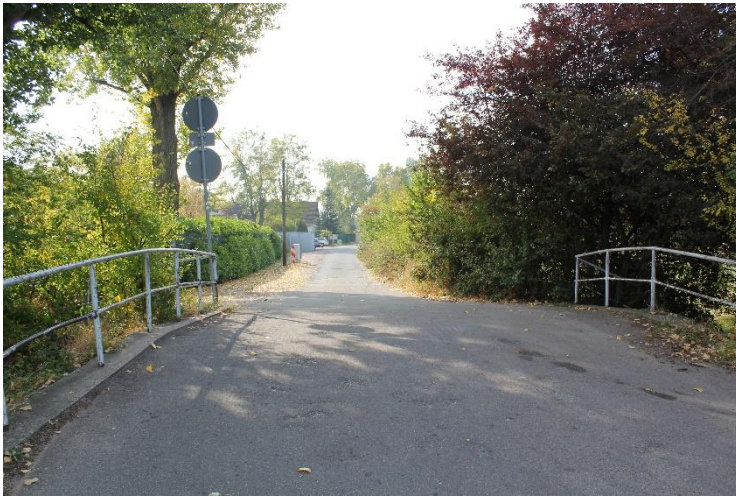
Abbildung 39: Brückenbauwerk über den Rehbach im Bereich Adolf-Kolping-Straße, Blick Richtung Süden
