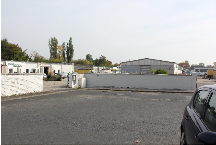
Abbildung 33: Gewerbegebiet Rosslauf, Blick Richtung Osten
