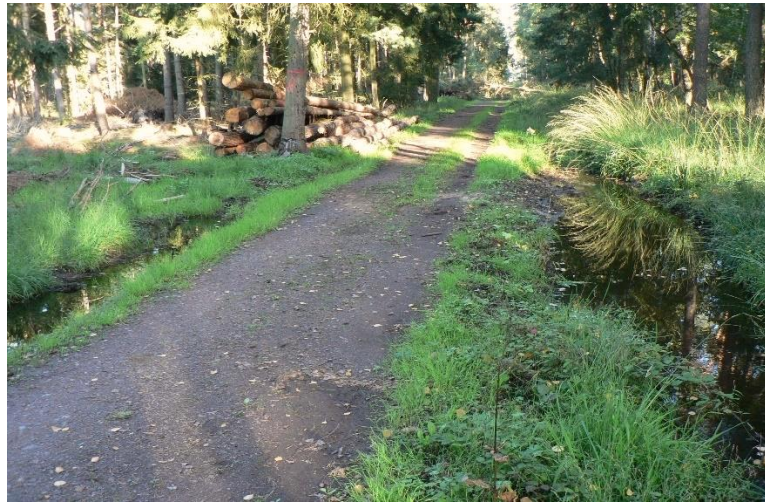
Bild 26 : Wassereinleitung in wegebegleitenden Graben am Hüttweg - Ordenswald
