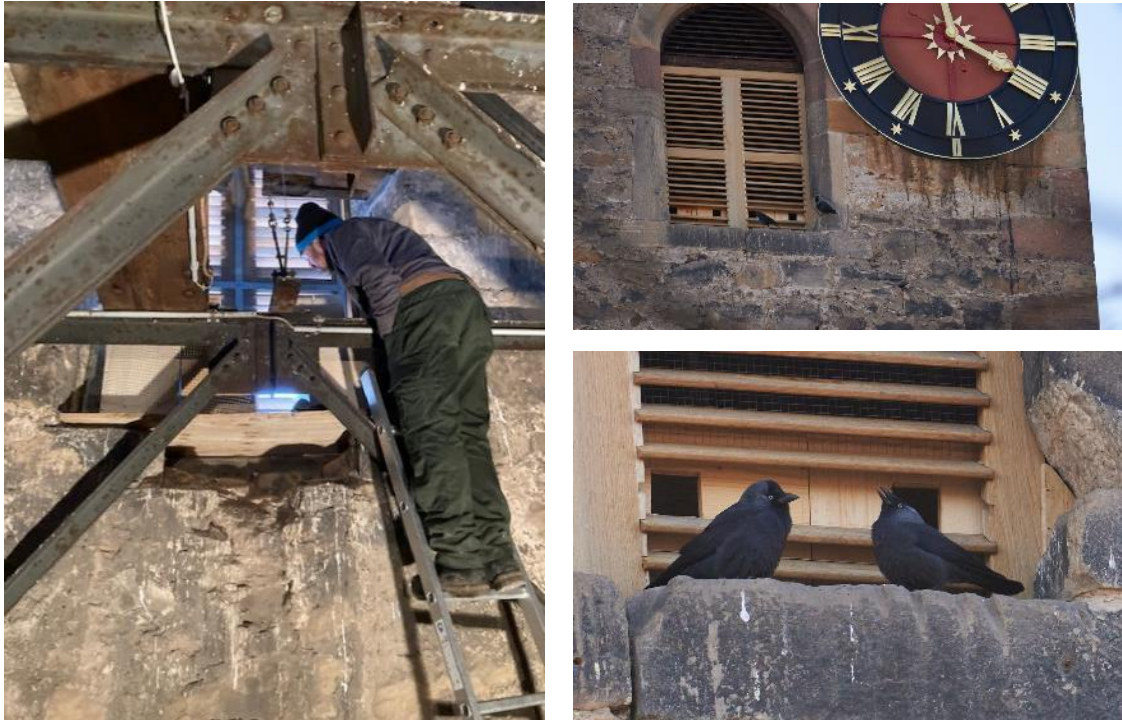
Abbildung 85: Gebäudebrüter - Dohlen am Mußbacher Kirchturm 177
