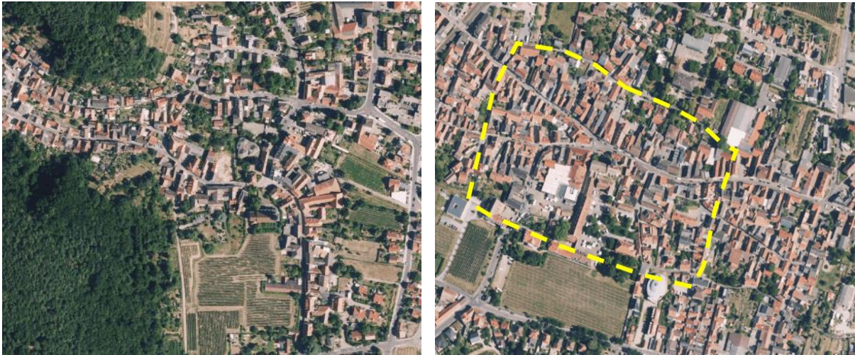
Abbildung 11: Die dicht bebauten historischen Ortskerne von Oberhambach (links) und Mußbach (rechts, mit mutmaßlichem Verlauf der früheren Dorfbefestigung) im Luftbild 38
