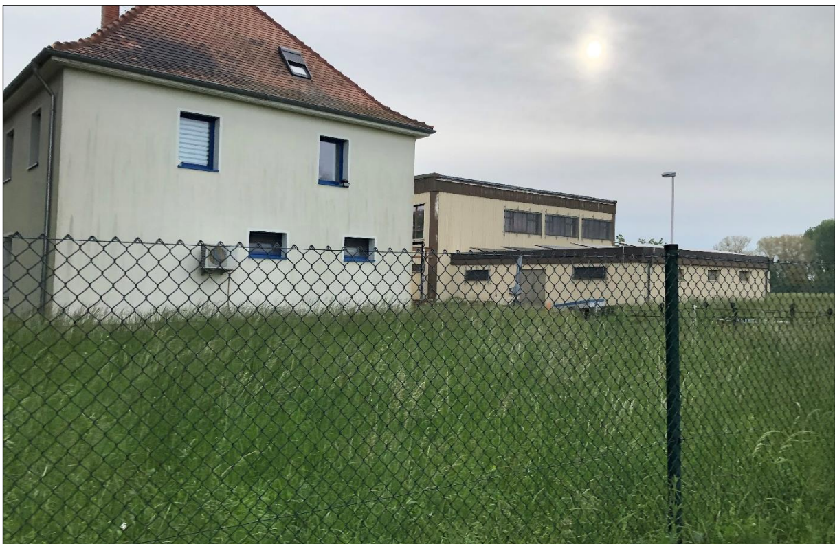
Landschaftsbildeinheit 4: Wasserwerk Benzenloch westlich der geplanten PV-Fläche 3 (Blick Richtung Nordosten).
