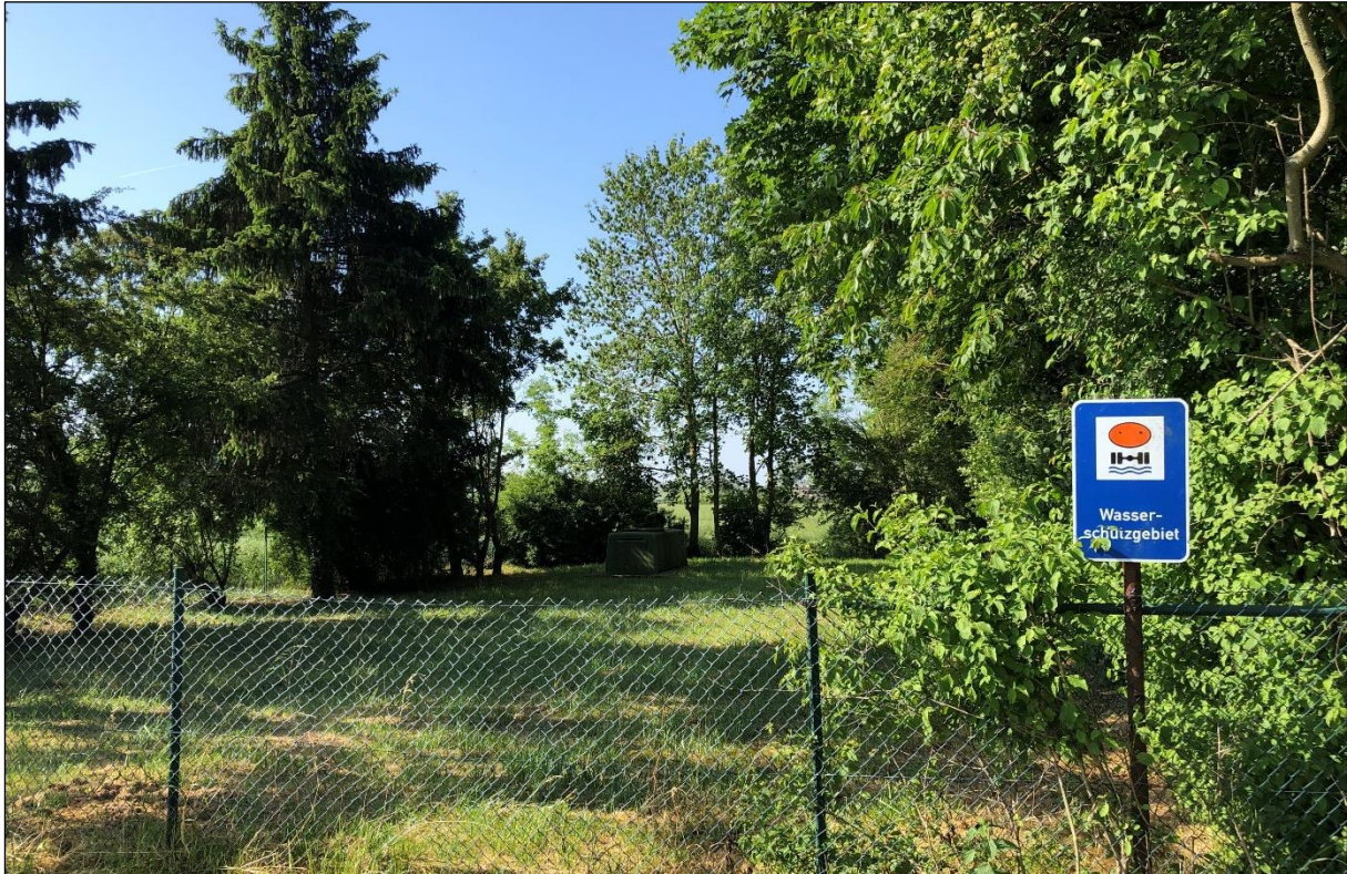
Landschaftsbildeinheit 4: Pumpstation des Wasserwerks Benzenloch nordwestlich der geplanten PV-Fläche 3 (Blick Richtung Südwesten).
